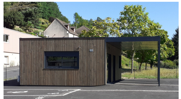
bâtiment d'accueil des candidats_crédits photos DDT 19
